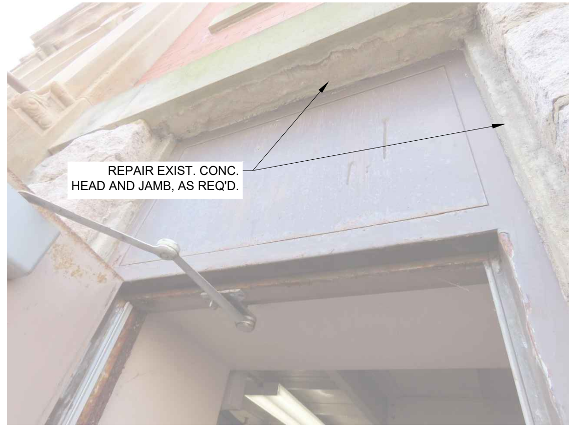
1.5 Existing Transom and Header N.T.S.
