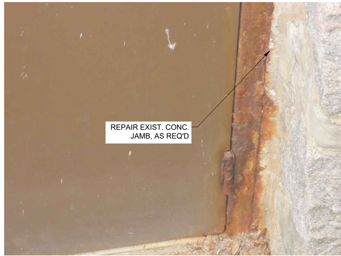
1.2 Existing Jamb Condition N.T.S.
