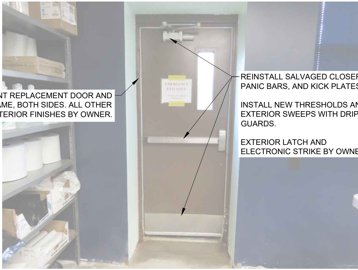
1.7 Existing Interior N.T.S.
