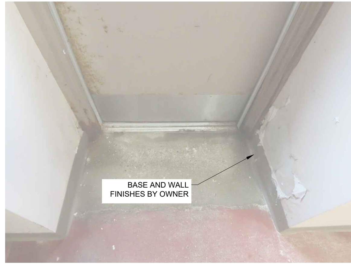
1.8 Existing Interior N.T.S.
